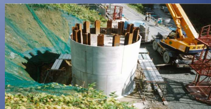
コンクリート打設
