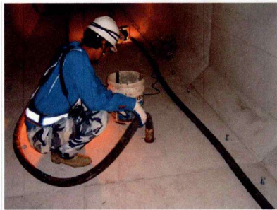
圧入ポンプ等を使用してのグラウト作業(1:2)
