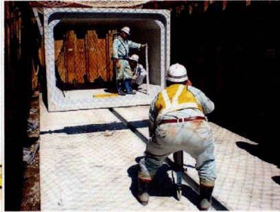
レベル測量器等を使用しての精度の高いmm単位の据付作業
