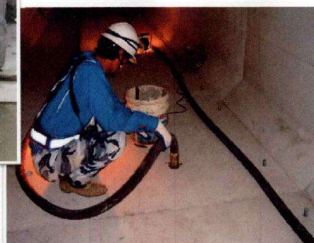
圧入ポンプ等を使用してのグラウト作業(1:2)
