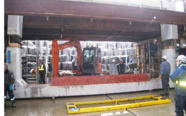
③ 上部カルバート設置状況
