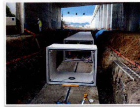
高架下でのボックスカルバート搬送作業
