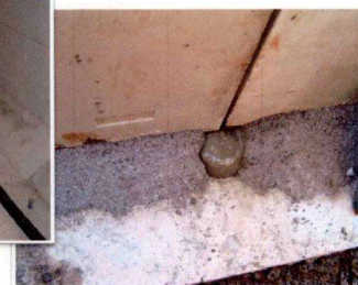
グラウト点検孔よりグラウト充填状況の確認
