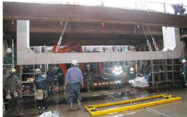
② 下部カルバート搬入状況
