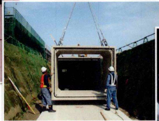
ボックスカルバート据付施工
