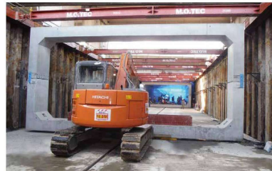
④ 2分割ボックスカルバート製品搬送状況
