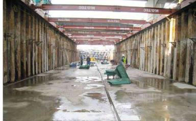
① 走行ガイド設置状況
