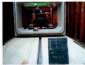
雨水対策ボックスカルバート搬送作業
