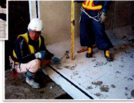
マルチレベル治具Ⅰを市販のレンチ等で回す事により上下の調整作業
