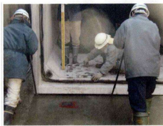
ボックスカルバート据付作業
