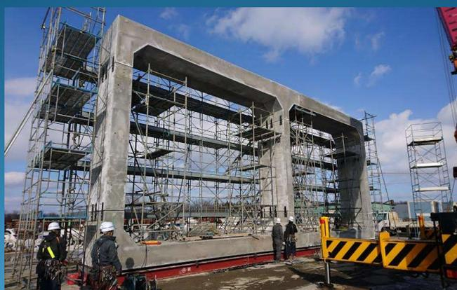
機械式継手を有効活用することで、従来は現場打ち施工またはハーフプレキャスト工法で構築していた大型構造物を、オールプレキャスト工法で構築し工期短縮を図れることを実証できました。
