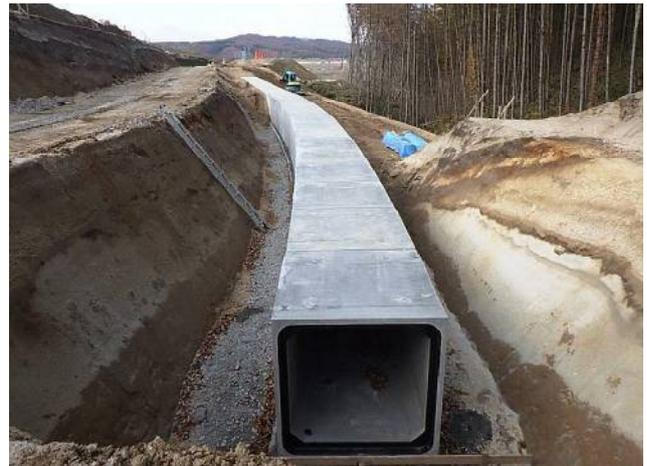
標準製品の差込長の調整による曲線施工
